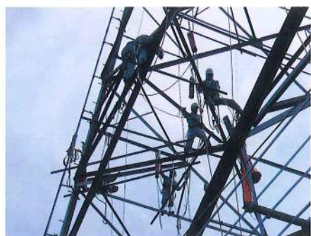
首都圏での電力用鉄塔の作業には、主にFRP足場材が使用されています。
